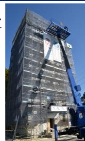
実験棟(工事中)
