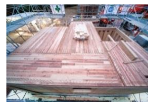
2階CLT床(工事中)
